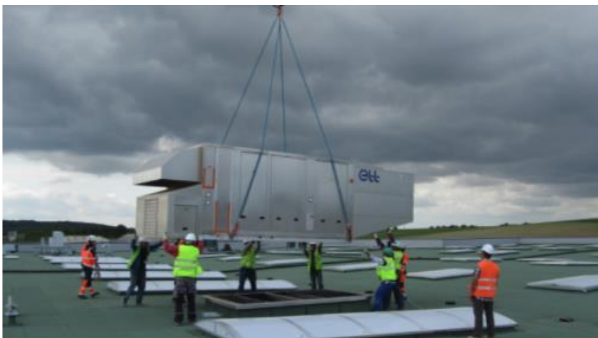
Réception du matériel sur toiture transporté par l'hélicoptère.
