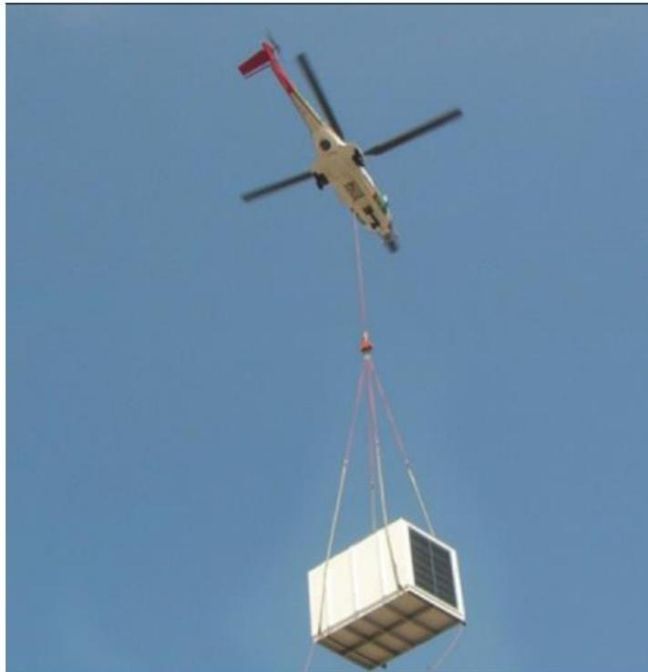
L'héliportage, une solution retenue pour installer les pièces de gaine sur une toiture.
